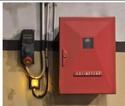
Exemple coffret pompier en extrémité de tube
