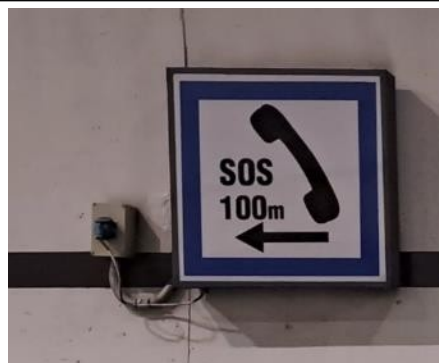
Exemple de CE2a en extrémité de tube
