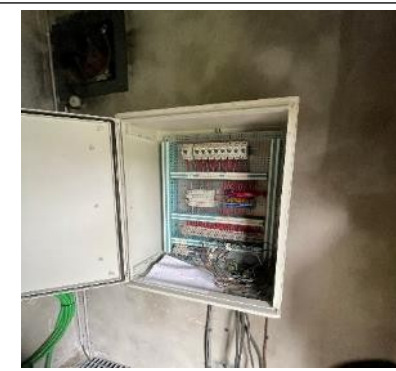
Armoire FAV du local technique secondaire Protections + actionneurs
